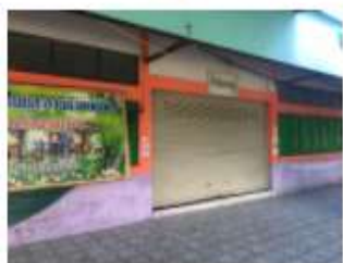
อาคารอเนกประสงค์/โรงอาหาร/โรง ฝึกงาน/หอประชุม สปข.202/26 ปีที่สร้าง 2531
