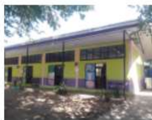
อาคารเรียน สปข.102/26 ปีที่สร้าง 2558
