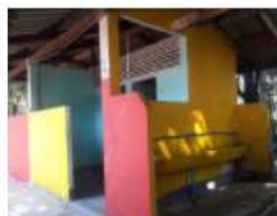
ส้วม สปข.601/26 ปีที่สร้าง 2532
