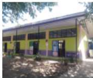
อาคารเรียน สปข.102/26 ปีที่สร้าง 2558
