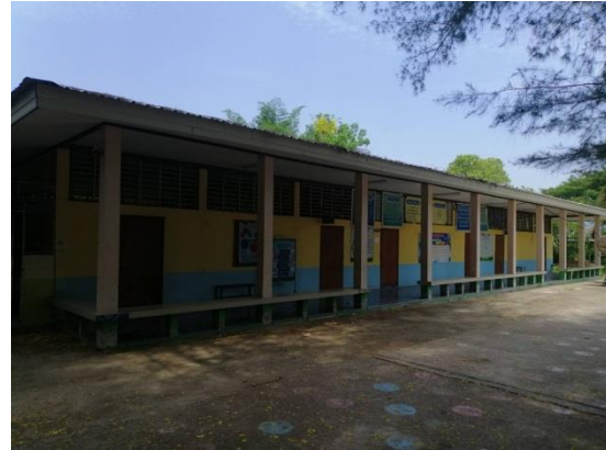
อาคารเรียน ป.4 ป.5, ป.6 , สำนักงานครู
