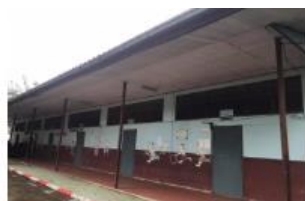
อาคารเรียน สพข.102/26 ปีที่สร้าง 2553
